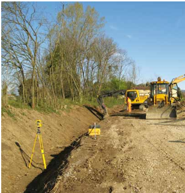
La squadra di operai impegnati nella realizzazione del Fossalon.
